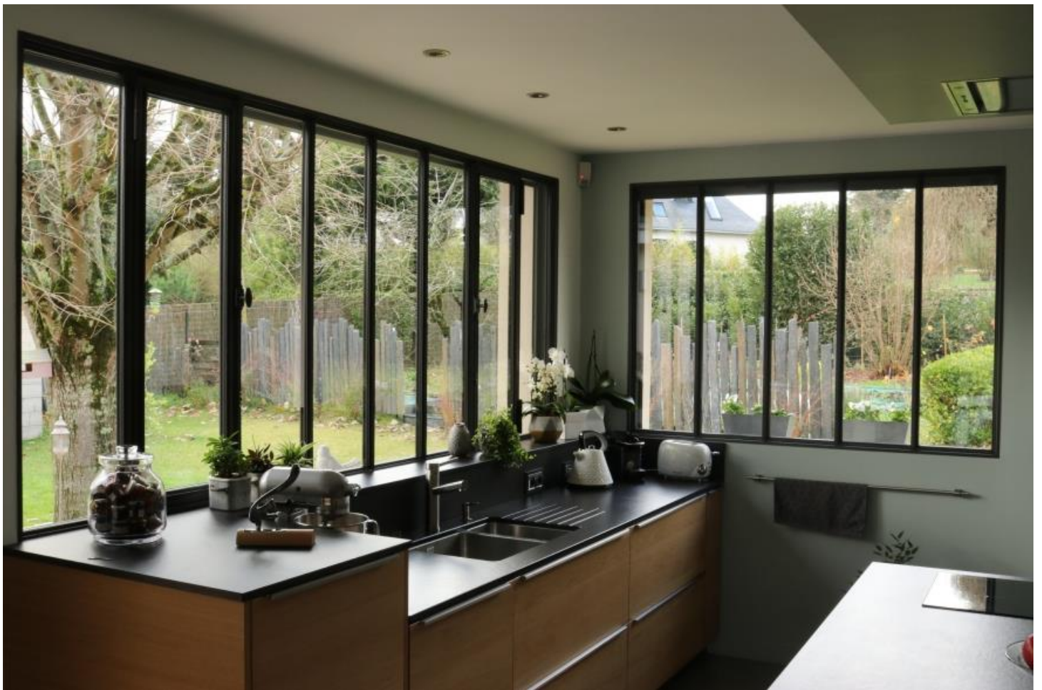
↑ Ensemble de menuiseries en acier pour ouvrir la cuisine sur le jardin. Coopération avec le cuisiniste pour une parfaite jonction des menuiseries avec le plan de travail. À Angers – Maine & Loire
